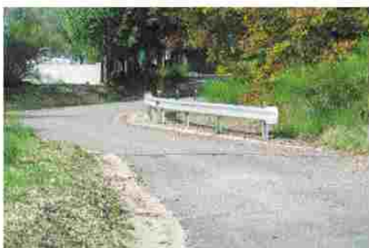
CONSOLIDAMENTO TRATTO STRADA DELLA PALOMBINA
