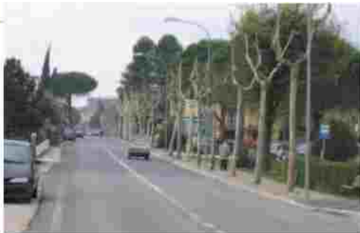
ACCORDO CON PROVINCIA PER ASFALTATURA TRAVERSA INTERNA
