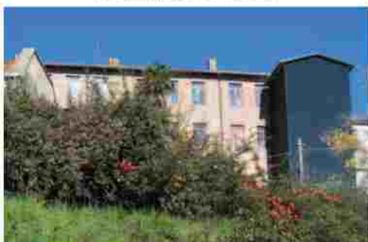
CHIUSURA SCALA SICUREZZA SCUOLA
