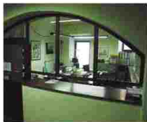
RISTRUTTURAZIONE UFFICI COMUNALI
