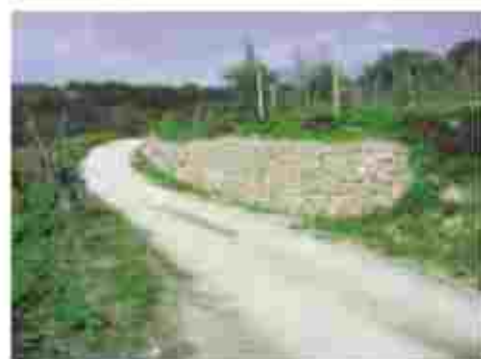
CONSOLIDAMENTO TRATTO STRADA DI PISCICOLI
