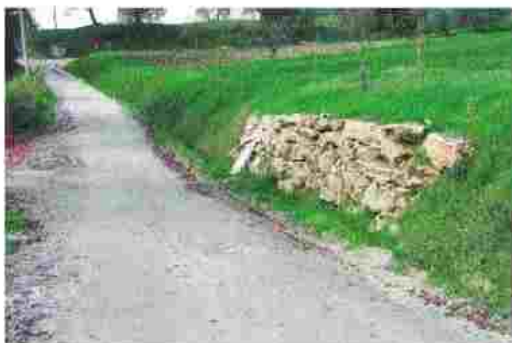
CONSOLIDAMENTO TRATTO STRADA DEI RIPI
