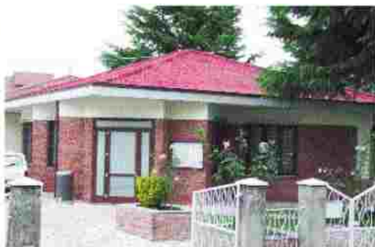
RISTRUTTURAZIONE SEDE PUNTO EROGAZIONE SERVIZI ASL
